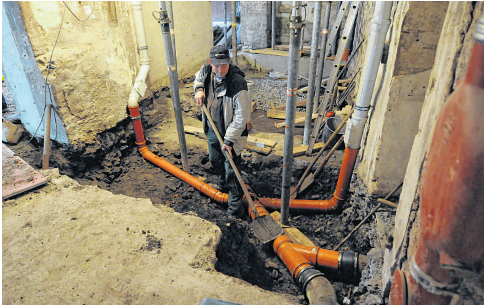
Die Sanierungswelle am Fritz-Kühn-Platz endet nicht an den Türen der umliegenden Gebäude. IGW-Mitarbeiter Jens Geßler ist derzeit in der Erdgeschoss-Wohnung des Fachwerkhauses an der Ecke Am Zeughaus beschäftigt. Der Fußboden vor ihm muss noch abgetragen werden – von Hand.
