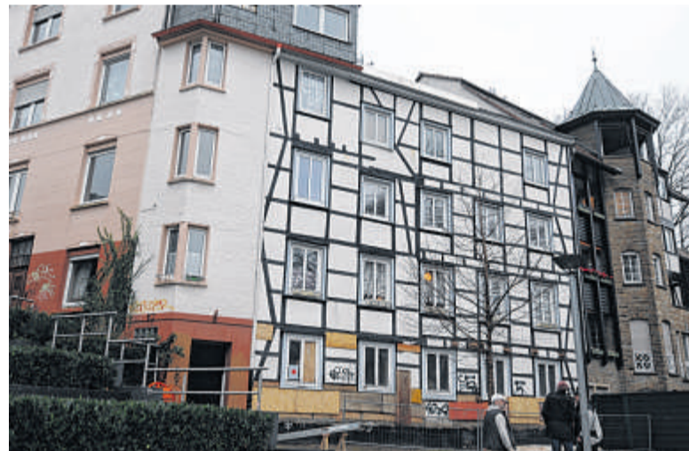
Ins Erdgeschoss dieses Fachwerkhauses zieht im April der Bürgerverein Iserlohner Südstadt ein. Der Umbau der Wohnung läuft auf Hochtouren.
